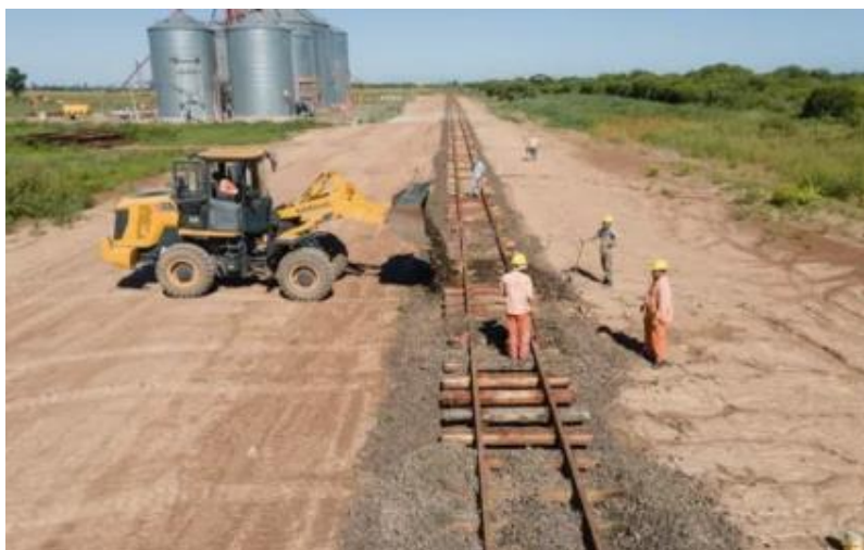
Imagen 8. Construcción desvío ferroviario Ramal C. Fuente:
